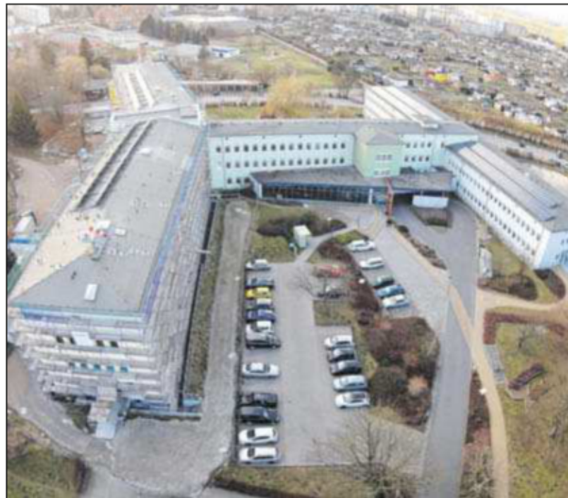
Seit Wochen heftig in der Debatte: die Zukunft des weitgehend sanierten Kreiskrankenhauses an der Wolgaster Chausseestraße.
